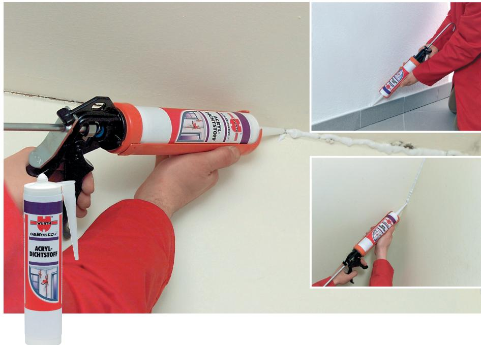
**Za zaptivanje fuga niske ekspanzije, u unutrašnjem području.**
