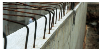
Beton, jako armir. (≥ 25 mm)
