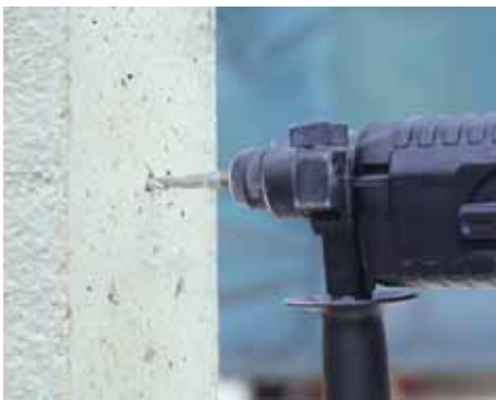
Sa elektropneumatskim čekićem izbušiti rupu za tiplu.
