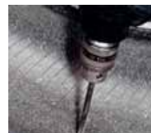
2. Izmjeriti oštećeno mjesto. Probušiti kanal iznutra prema van.
