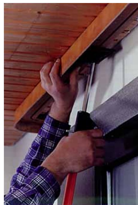
Pričvršćavanje nosača zavjesa, lampi itd.
