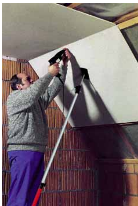
Pričvršćavanje gips-kartonskih ploča.
