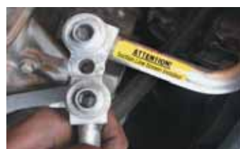
7. Etikete sa napomenama postaviti na usisni vod.
