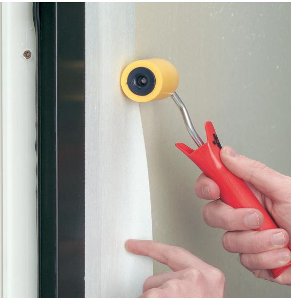
**Veoma elastična zaptivna traka za prozore sa zonom istezanja i dvostrukom ljepljivom trakom.**
