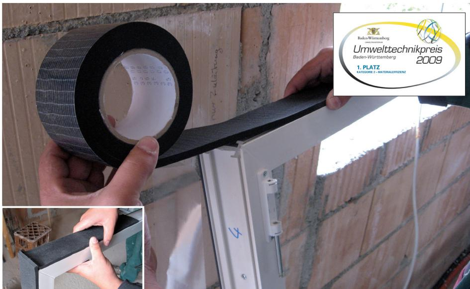
**Zaptivna traka za istovremeno zaptivanje i izoliranje unutrašnjih i vanjskih fuga prozora i vrata**
