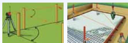
Postavljanje pravog ugla Poslovi nivelisanja temeljnih i međuspratnih ploča
