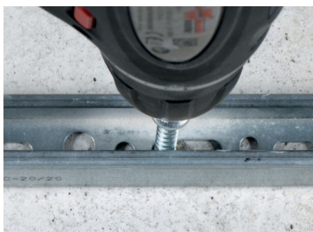
Pričvršćivanje sa montažnim vijkom za šine tip MS za C šinu 26/18
