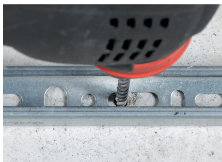
Pričvršćivanje sa montažnim vijkom za šine tip MS za C šinu 26/18
