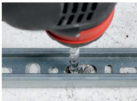
Pričvršćivanje sa plastičnom tiplom za ramove W-UR za C šinu 26/18
